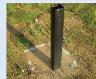
上から土をかぶせれば、景観も損ねない自然な仕上がりになります
